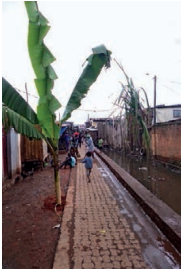
Calle pavimentada con adoquines ecológicos y el canal de saneamiento, Madagascar
